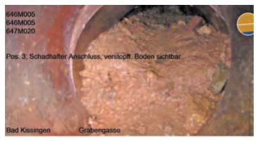
Es gibt viele Gründe, warum Hausanschlüsse undicht werden: altersbedingter Verschleiß, beschädigte Muffen oder Dichtungen, Verlegefehler, eingebrochene Kanalrohre, Boden, Geröll und Wurzelwerk, Der Eigentümer muss iedoch eine intakte Grundstücksentwässerungsanlage (GEA) betreiben.
