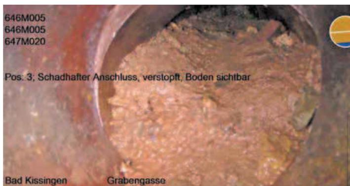
Es gibt viele Gründe, warum Hausanschlüsse undicht werden: altersbedingter Verschleiß, beschädigte Muffen oder Dichtungen, Verlegefehler, eingebrochene Kanalrohre, Boden, Geröll und Wurzelwerk. Der Eigentümer muss jedoch eine intakte Grundstücksentwässerungsanlage (GEA) betreiben.
