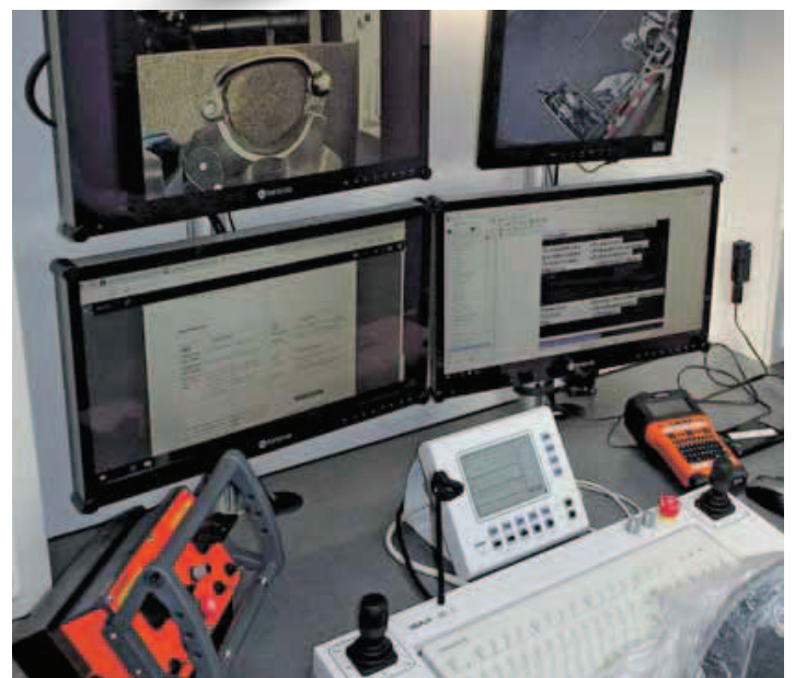
Der Arbeitsplatz des „Inspektors“ im Kanal-TV-Fahrzeug. Er fährt den Kanal-Kamera-Wagen mit der Funkfernsteuerung und dokumentiert die Live-Untersuchung
