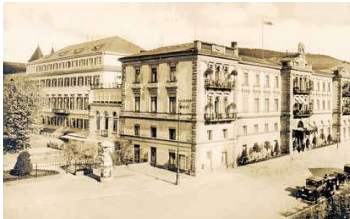
Der Fremdeneingang führte über einen Treppenabgang (rechts neben der Litfaßsäule) in den Kanal der Kurhausstraße. Durch den Rückbau im Winter 1984/85 ist er nicht mehr nutzbar. Quelle: Postkartensammlung Bötsch Abb. 30 14-8, Stadtarchiv Bad Kissingen
