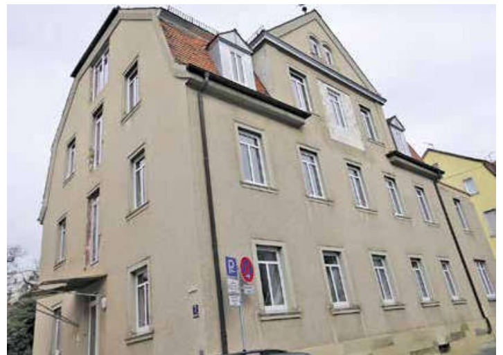
Während der Sanierung: Von außen ersichtlich sind neue Fenster und Balkontüren
