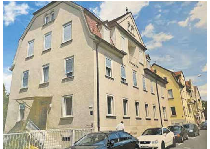
Vor der Sanierung: Gebäude mit Sanierungspotenzial. Foto: Dr. Bernd Weiß
