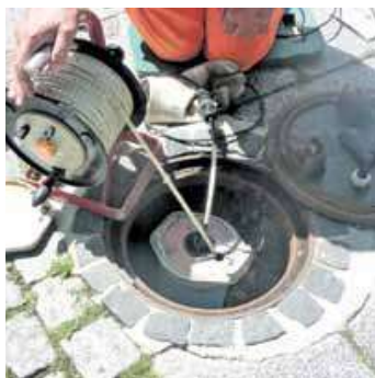
Der Messwert der Sonde wird mittels manueller Lichtlot-Messung überprüft
