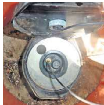
Eine Kappe schützt die darunterliegende Messstelle. Der Ringraum umschließt die Messstelle und ist auf Höhe des Filterrohres mit Filterkies, darüber zum Schutz vor Oberflächeneinflüssen mit Ton und Zement, dem sogenannten „Brunnendämmer“, abgedichtet.
